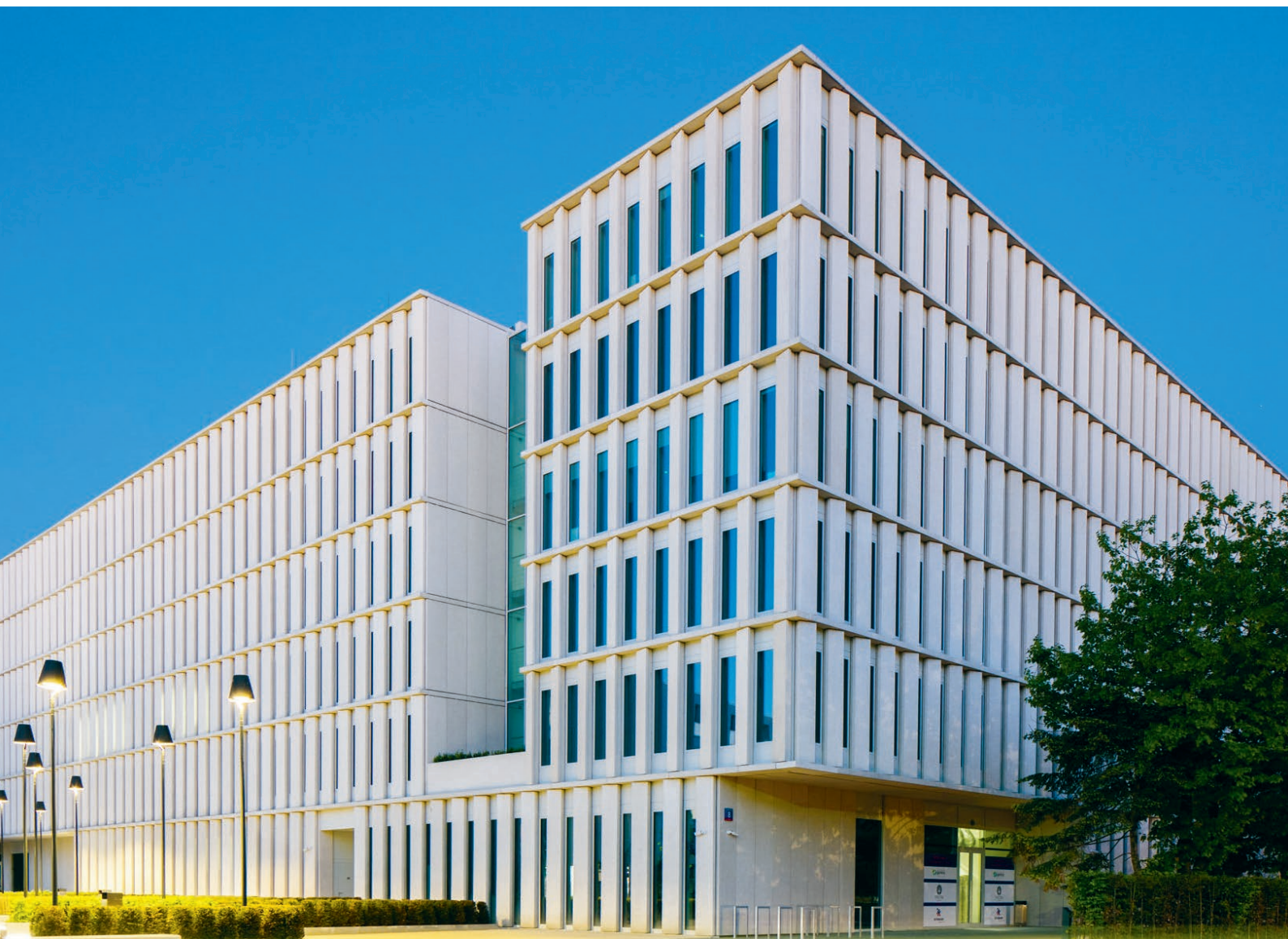
Nowa siedziba Roche Diagnostics Polska, ul. Bobrowiecka 8, Warszawa
